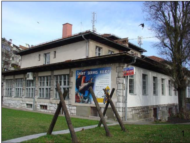
Pogled na objekt TVD Partizan z JZ strani.
